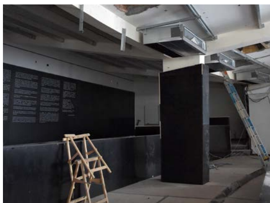
Travaux dans l'hémicycle en décembre 2020.
